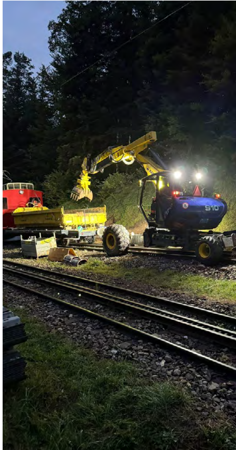
Nachtarbeit ermöglichte ein dichtes Bauprogramm und ein Minimum an Einschränkungen für den Tagesbetrieb der Zahnradbahnen.
