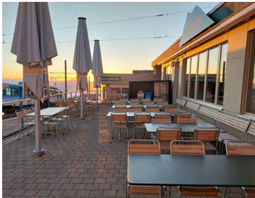
Mit der neuen Möblierung der Terrasse ist die Sanierung des Rigi Bistros abgeschlossen.
