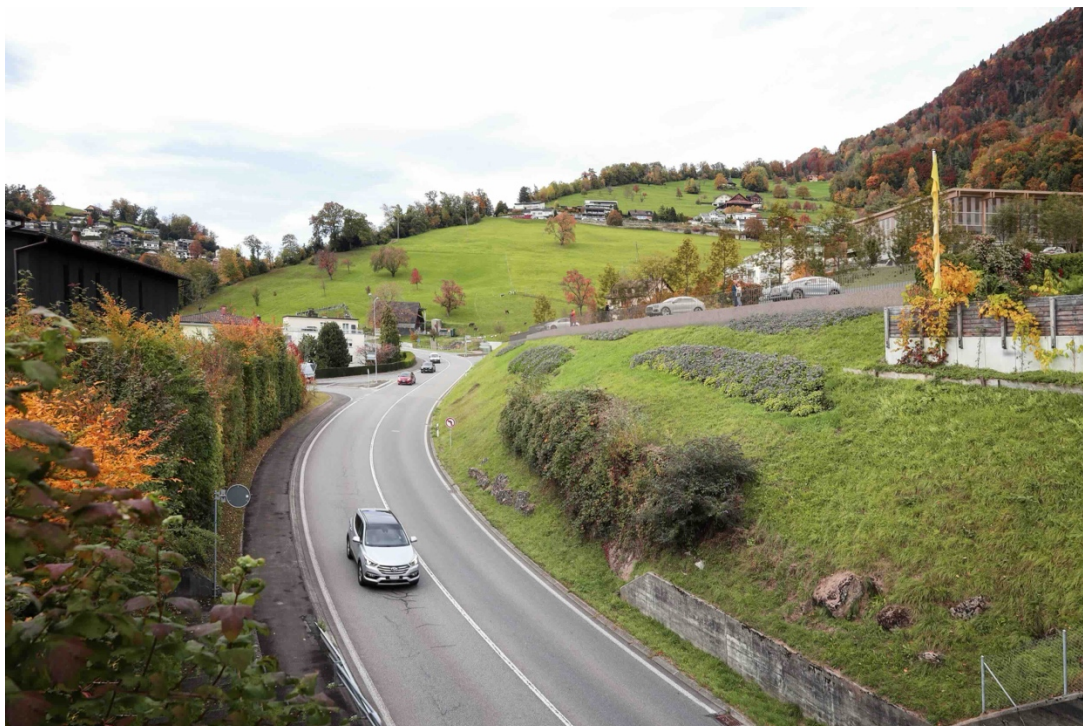
Abbildung 26: Visualisierung der neuen Situation mit Blick auf die Kantonsstrasse und höhergelegene umgestaltete und begrünte Parkierung Rigistrasse West und Bushub (Quelle: Rigi Bahnen)
